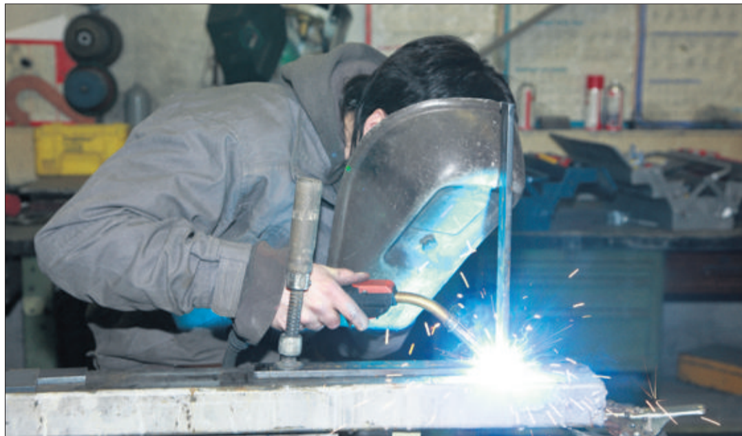
En vue: les constructeurs métalliques, les installateurs sanitaires et les ferblantiers. (DR)
